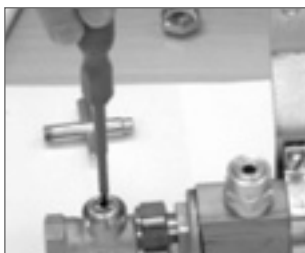
Рис. 37. Выполнение настройки на обратном вентиле
