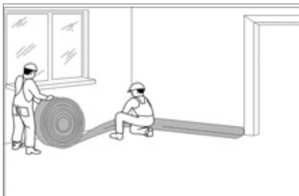
Рис.20. Раскладка под стеной краевой ленты.
